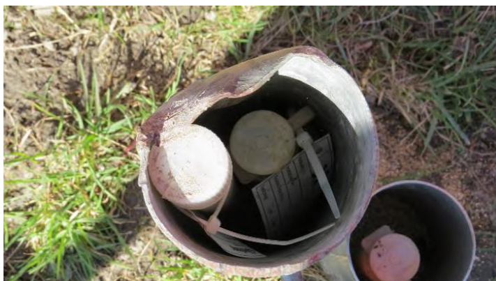
Figuur 4.2 Rijschade aan robuuste beschermkoker op afgesloten terrein en maaischade
